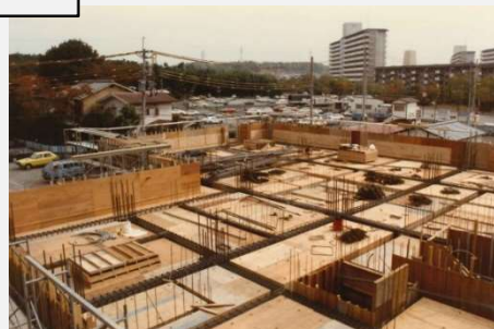
昭和 59 年 洛西寮建設中
